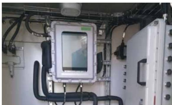
Установка производства МТБЭ / поставка промышленных газовых хроматографов МАГ в блок-боксах для измерения состава углеводородных продуктов — 4 комплекса
