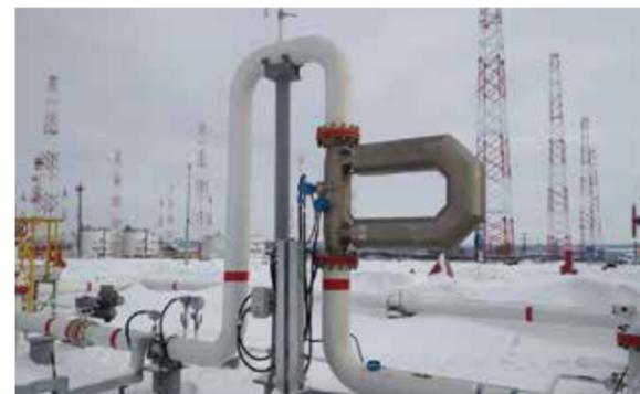
Система измерения массы нефтепродуктов на базе счетчика-расходомера массового МИР DN200
