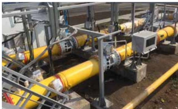
Блок входных устройств и коммерческий узел учёта природного газа, поступающего в комплекс сжижения ПГ и выходящего из комплекса на КСПГ
