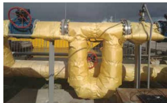
Система измерения массы нефтепродуктов на морском терминале на базе счетчика-расходомера массового МИР P200
