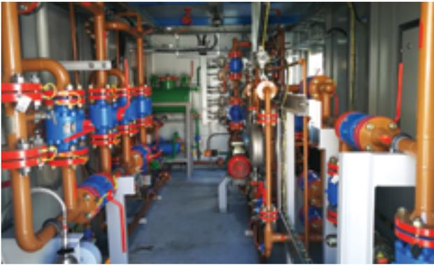
Системы измерения количества и показателей качества нефтеконденсатной смеси (СИКНКС) на ПСП и нефтеперекачивающей станции – 2 комплекса
