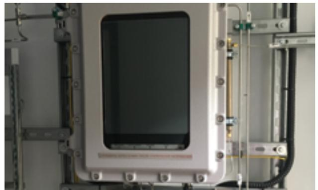
Italgas / Промышленный газовый хроматограф МАГ для определения компонентного состава природного газа и серосодержащих соединений в нём, анализа биометана – 5 комплексов
