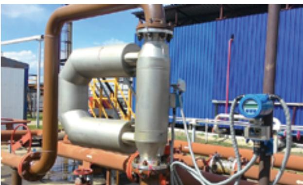
Система измерения количества и качества нефти сырой на базе счетчика-расходомера массового МИР DN 150
