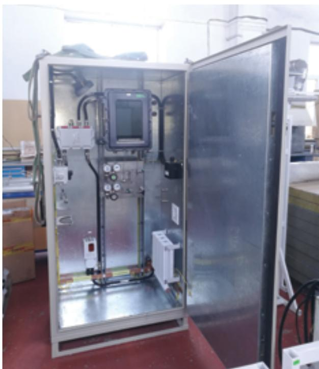
Потоковый газовый хроматограф МАГ для анализа синтез-газа и серосодержащих соединений в нём в блоке смешения с природным газом – 4 комплекса
