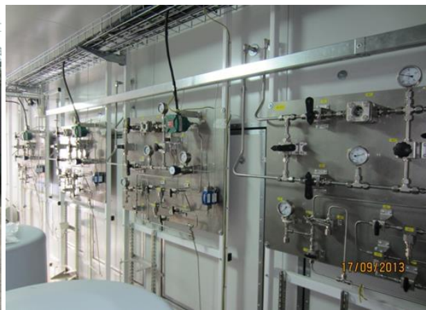
Блок контроля качества установки получения МТБЭ, АО «Ангарская НХК»
